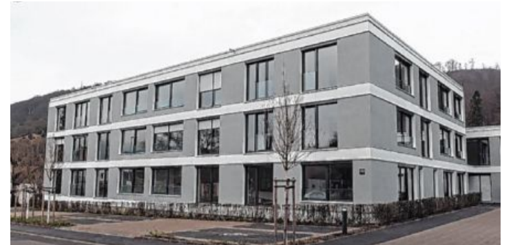
Der „Oberdorfer Hof“ ist nun fertiggestellt und an den Malteser Hilfsdienst übergeben worden. Foto: als
